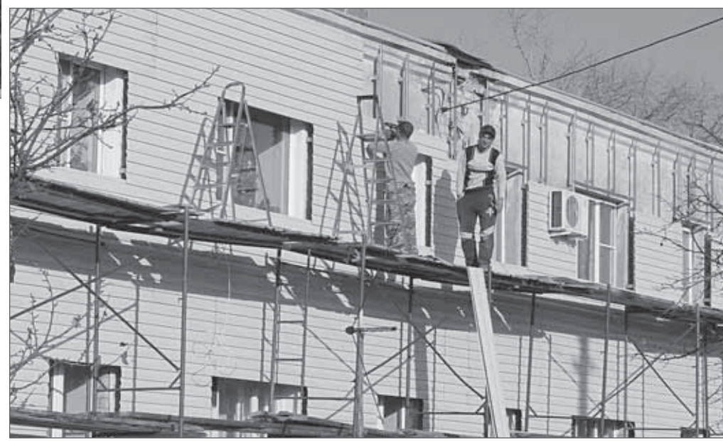
Многоквартирный дом по улице Ленина, 107 после и во время ремонта
