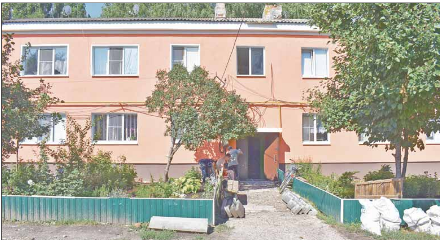
На улице Героя Колбнева строители завершили ремонт фасада
